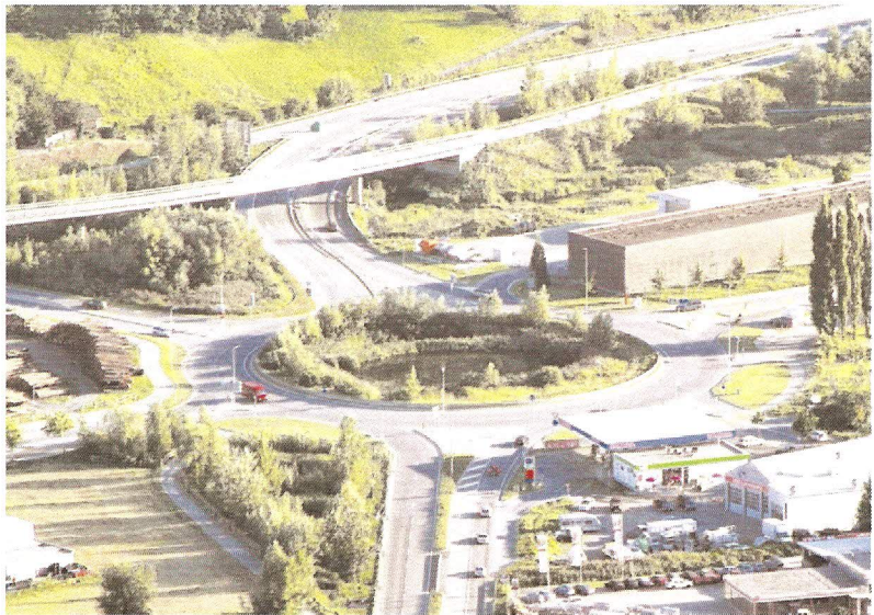
Mit Filter. Hinter dem Gürtel aus Schilf, Weiden und Buschwerk im Zentrum des Verkehrskreuzes Bildacker verbirgt sich eine der ersten Strassenabwasser-Behandlungsanlagen (SABA) des Kantons. FOTO WBO
